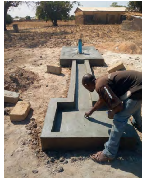
De stichting Hope bouwde in Ghana twee waterputten in de Nandom Municipal Area.
